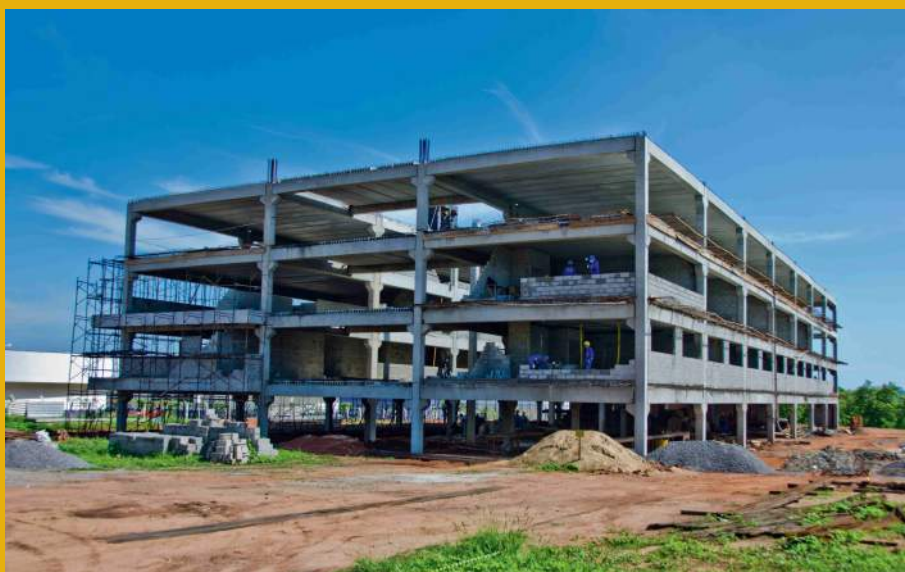
Obras na Ufersa em Mossoró
