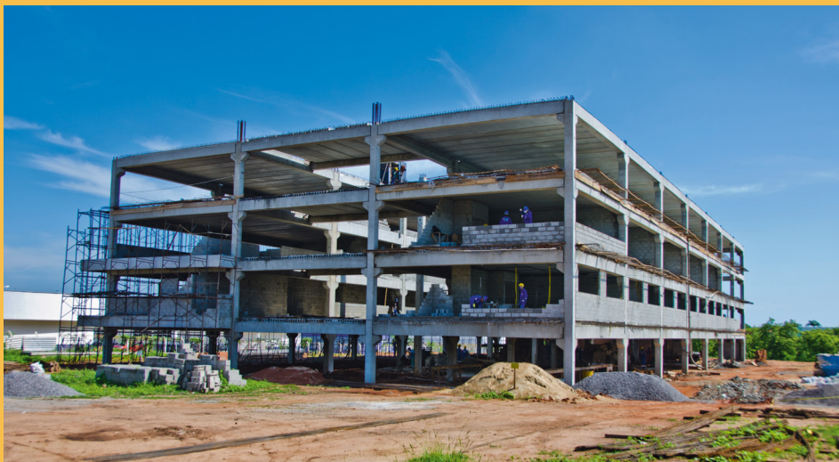
Obras na Ufersa em Mossoró
