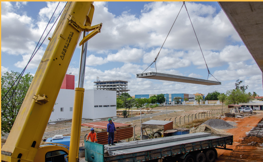
Obras consolidam o crescimento da Ufersa nos três câmpus da Universidade
