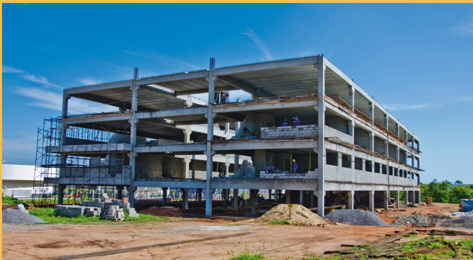
Obras na Ufersa em Mossoró
