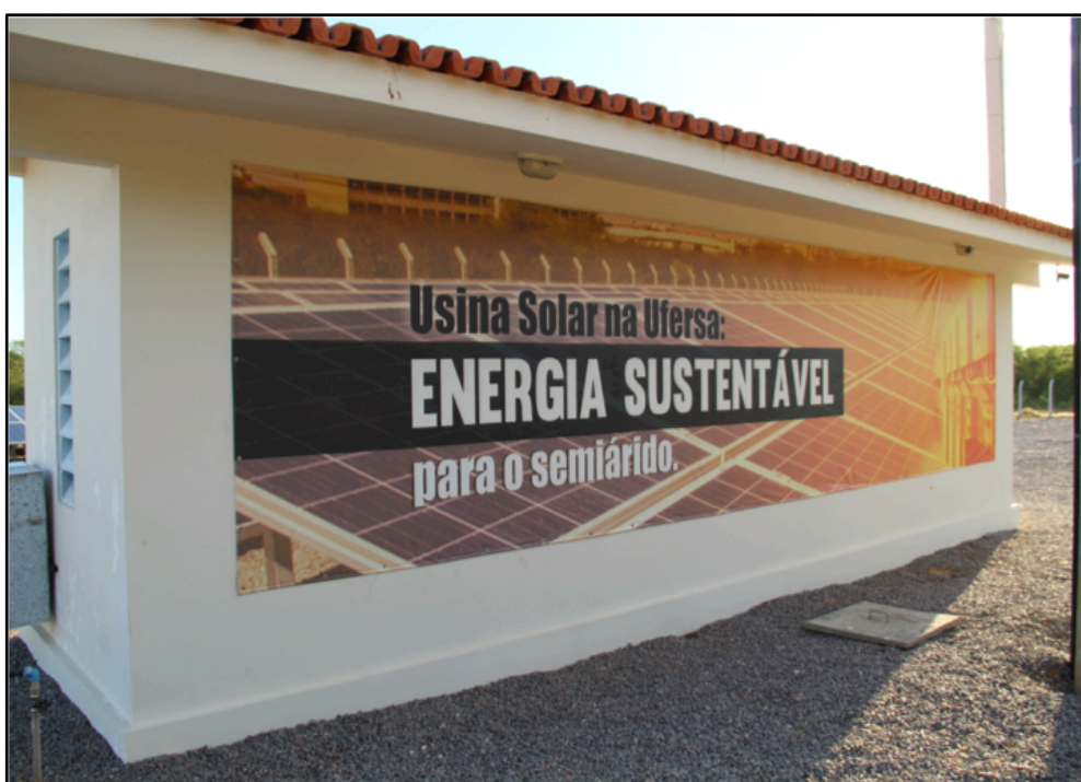
Abrigo de inversores de uma usina solar fotovoltaica da UFERSA, campus Mossoró.
