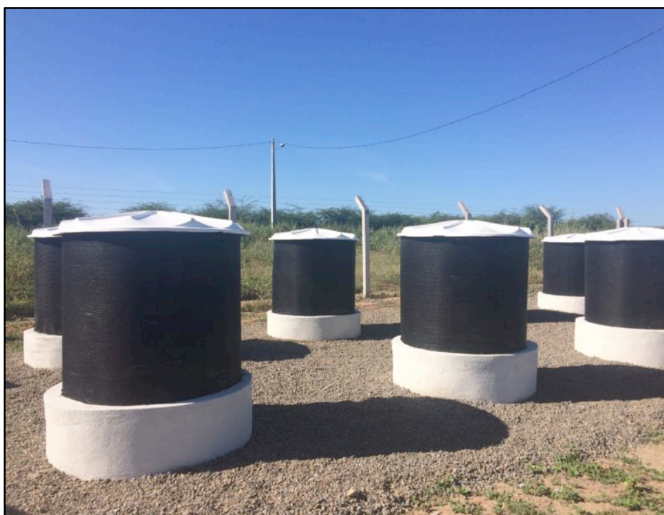
Usina de Compostagem termofílica da UFERSA, campus Mossoró, RN.
