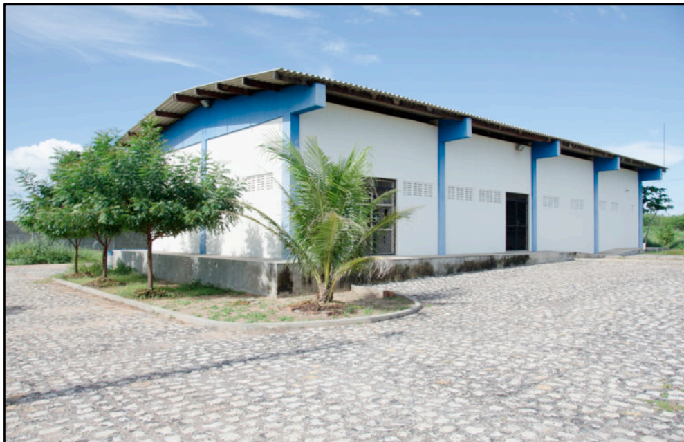
Abrigo temporário de resíduos da UFERSA, campus Mossoró, RN.
