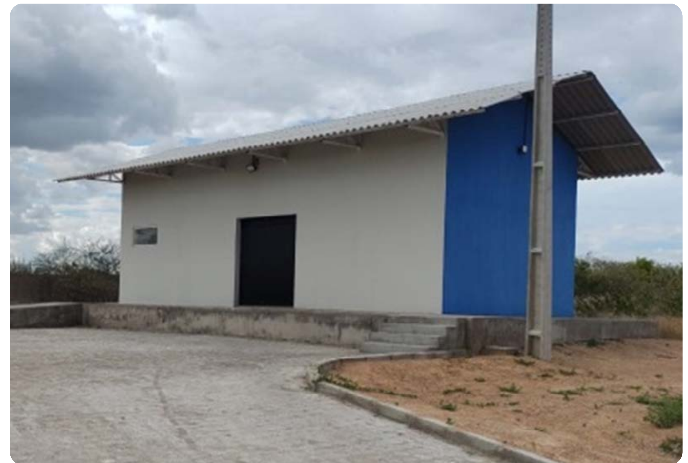
Figura 50 Abrigo de Resíduos em Caraúbas.
