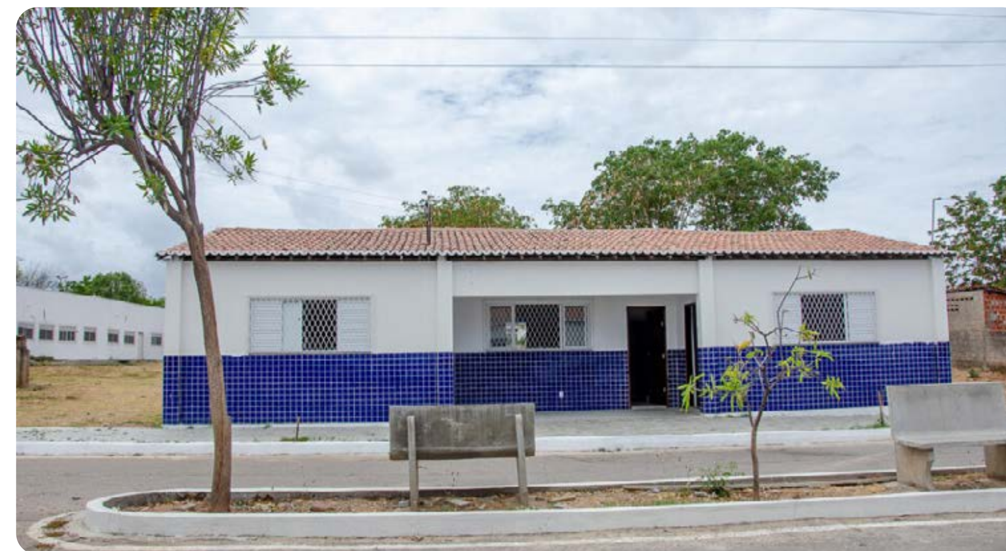
Figura 43 Reforma das casas da vila masculina no Campus Mossoró.
