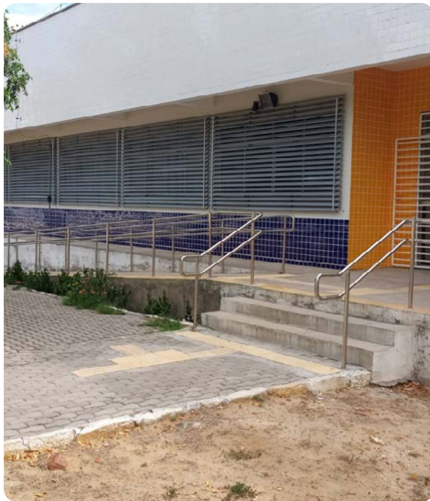
Figura 51 Instalação de Corrimão em prédios do Campus de Angicos.
