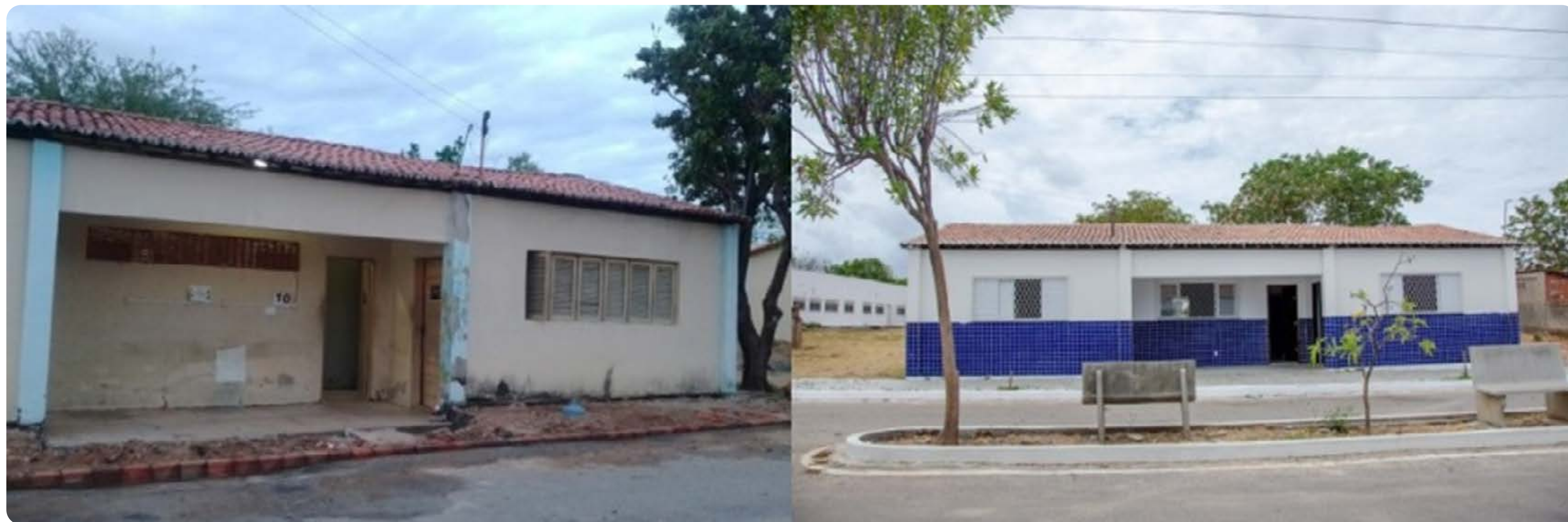
Figura 57 Antes e depois da Reforma da Vila Acadêmica Masculina, em Mossoró.
