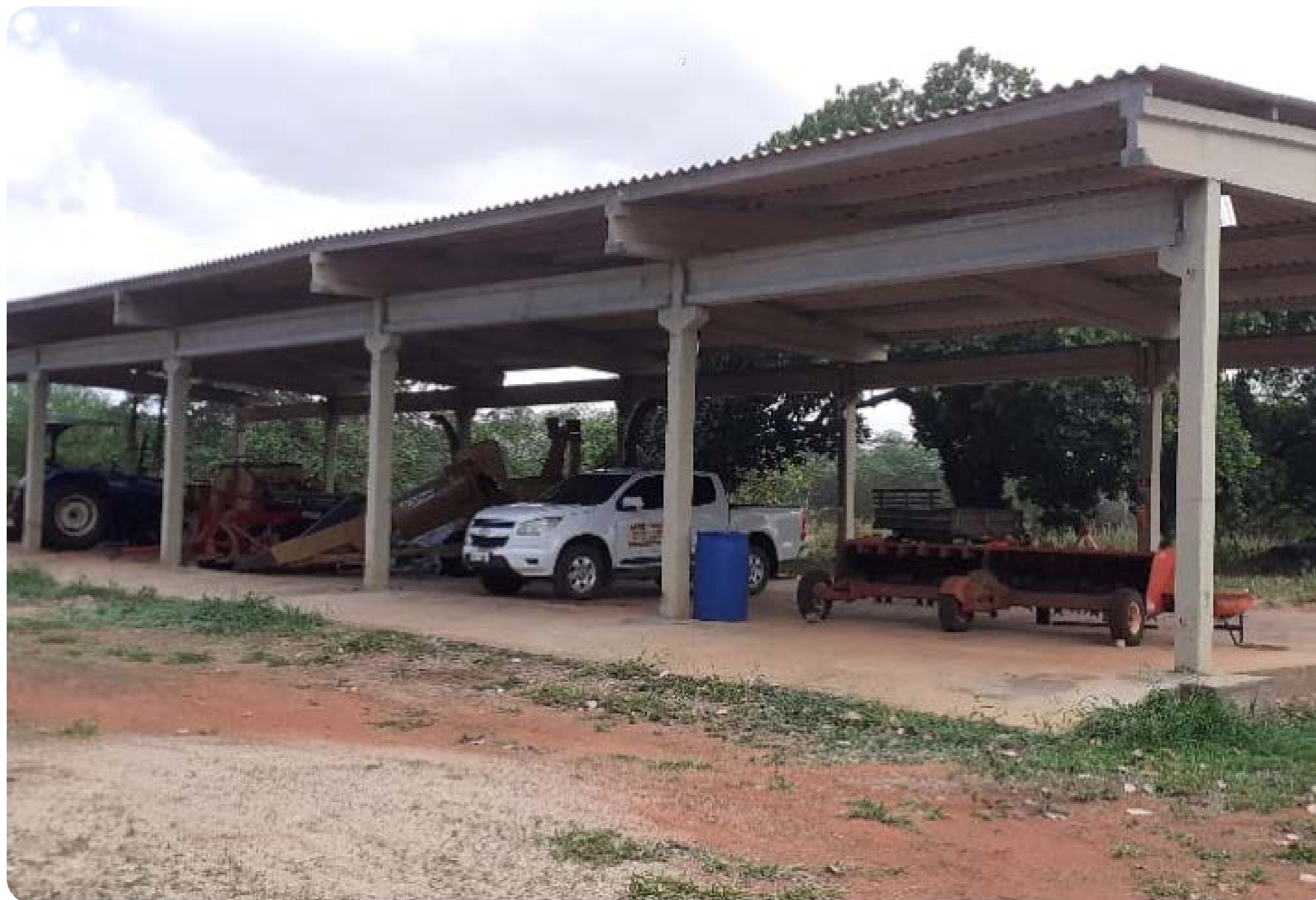
Figura 49 Galpão de Máquinas na Fazenda Experimental Rafael Fernandes.
