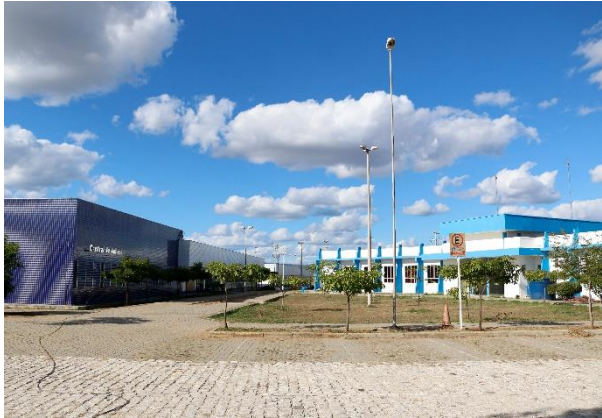
Prédio de Central de Salas de Aulas
