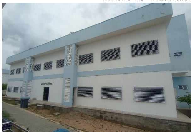
Prédio de Laboratórios I
