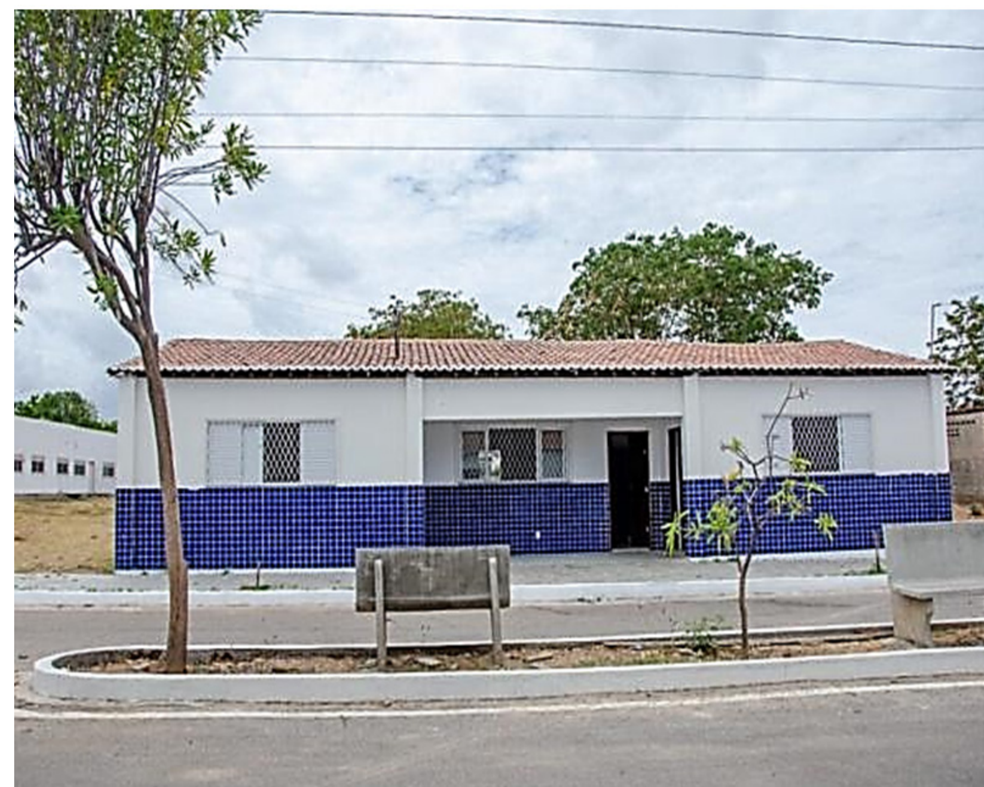
Figura 46 - Reforma das casas da vila masculina no Campus Mossoró.
