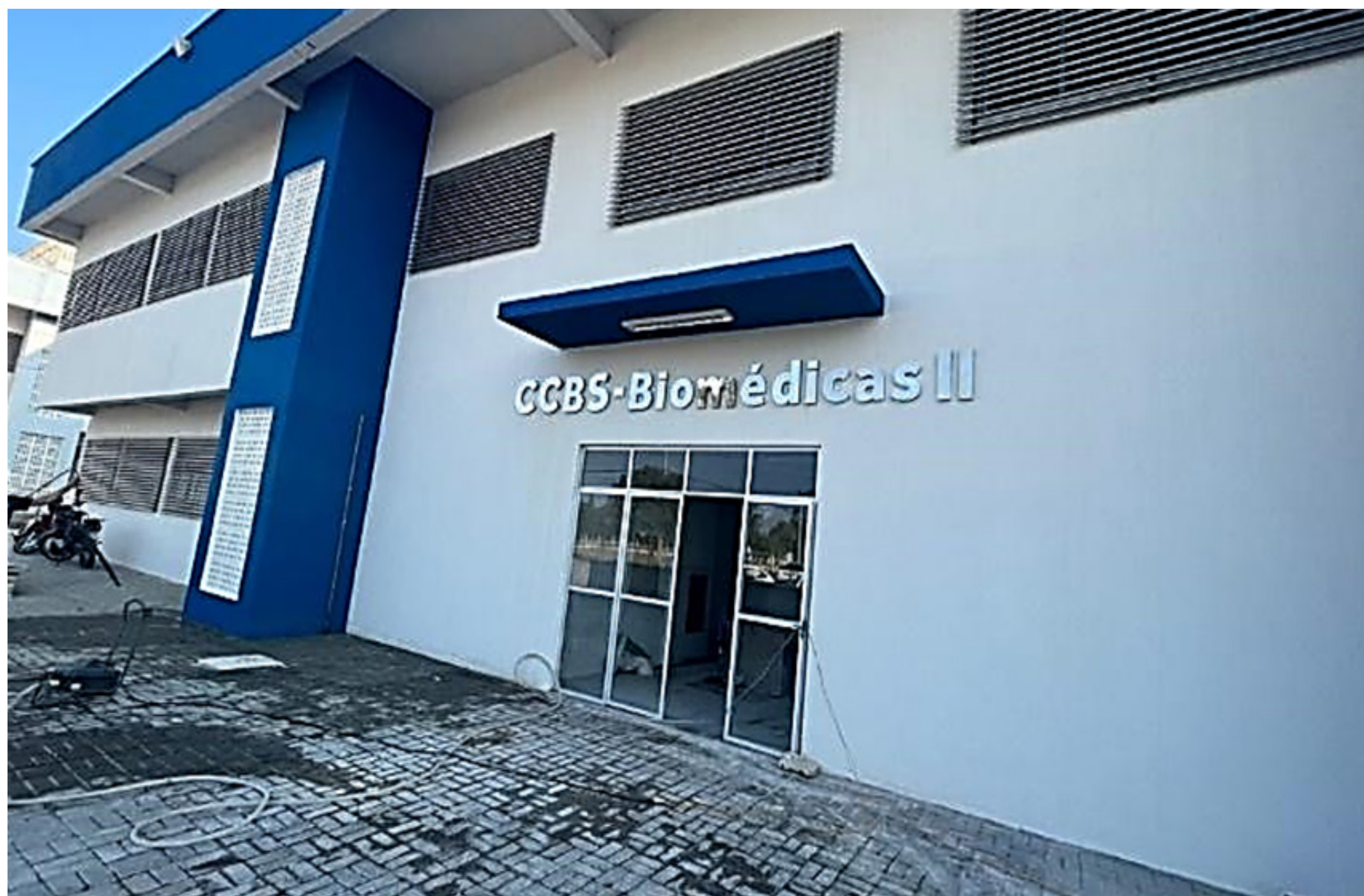
Figura 60 - Serviços remanescentes da construção do bloco administrativo e de salas de aula do Curso de Medicina - Bloco B no Campus Mossoró
