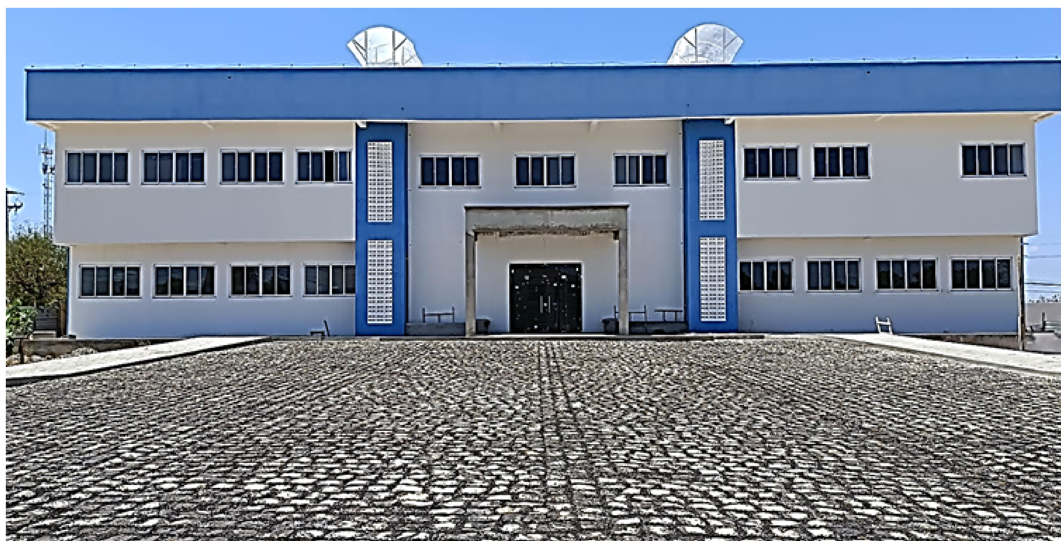
Figura 56 - Construção do Núcleo Integrado de Práticas das Ciências Sociais Aplicadas.
