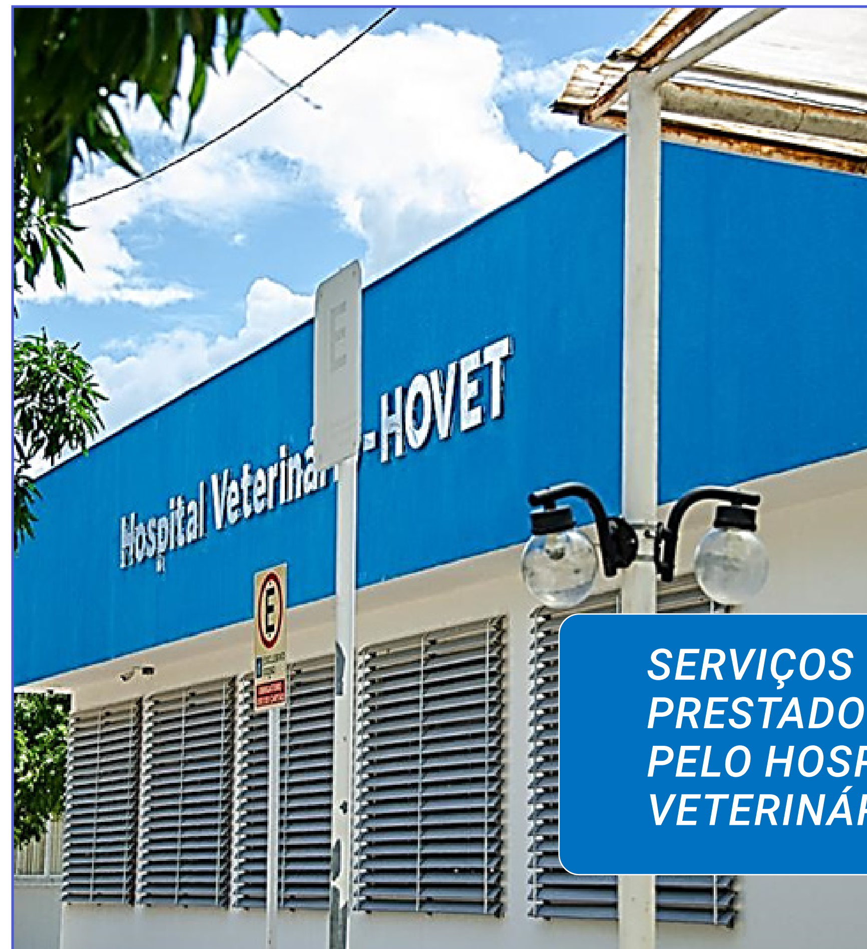
Figura 91 - Hospital Veterinário da Ufersa
