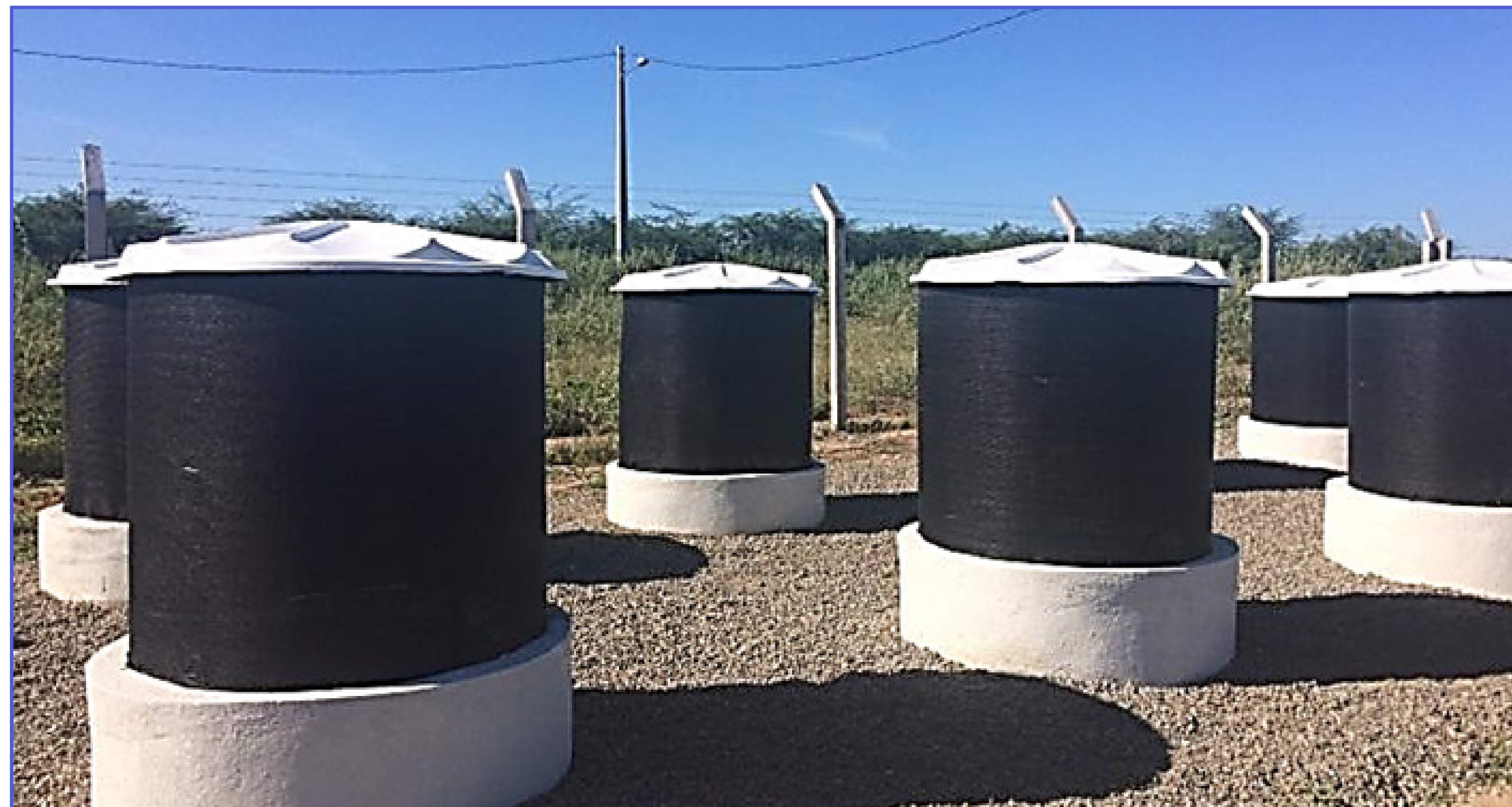
Figura 72 - Usina de compostagem do campus Mossoró da Ufersa
