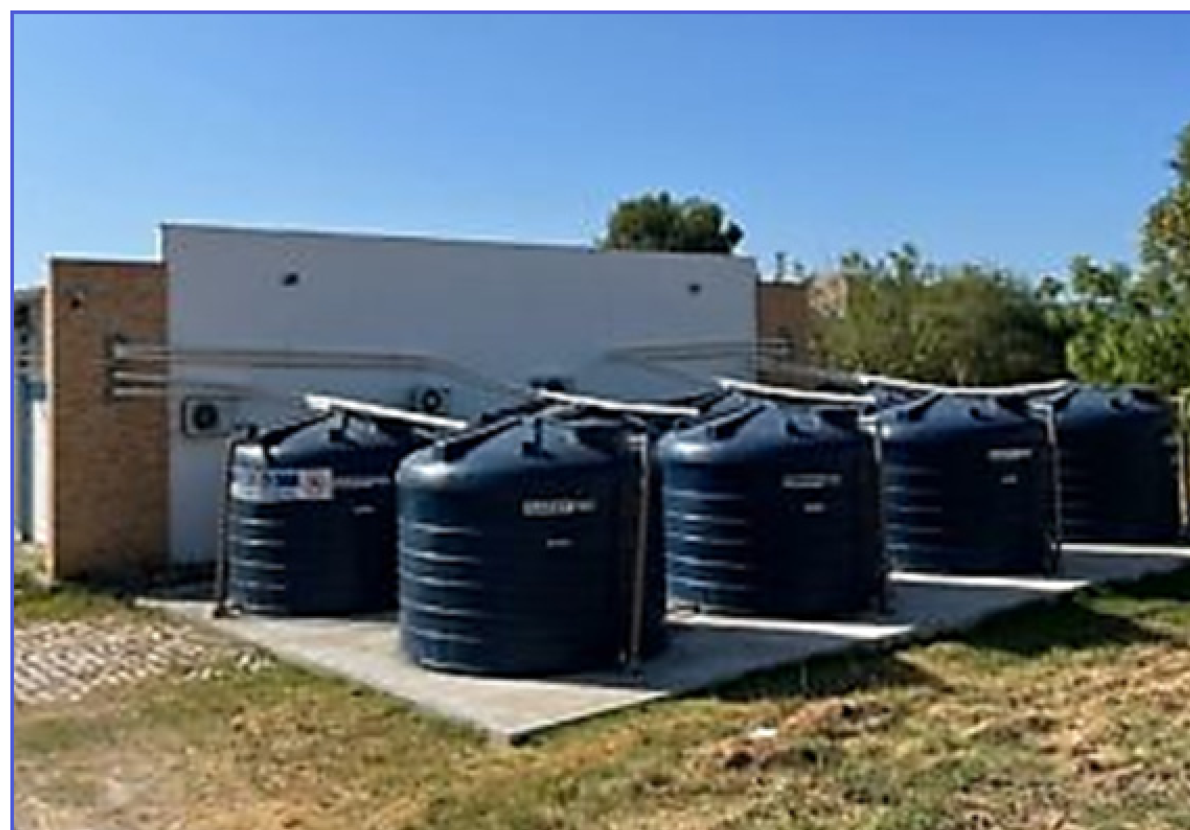
Figura 73 - Sistema de reuso de águas pluviais do complexo de Transportes, Patrimônio e Almojarifado (TPA) do Câmpus Mossoró/RN
