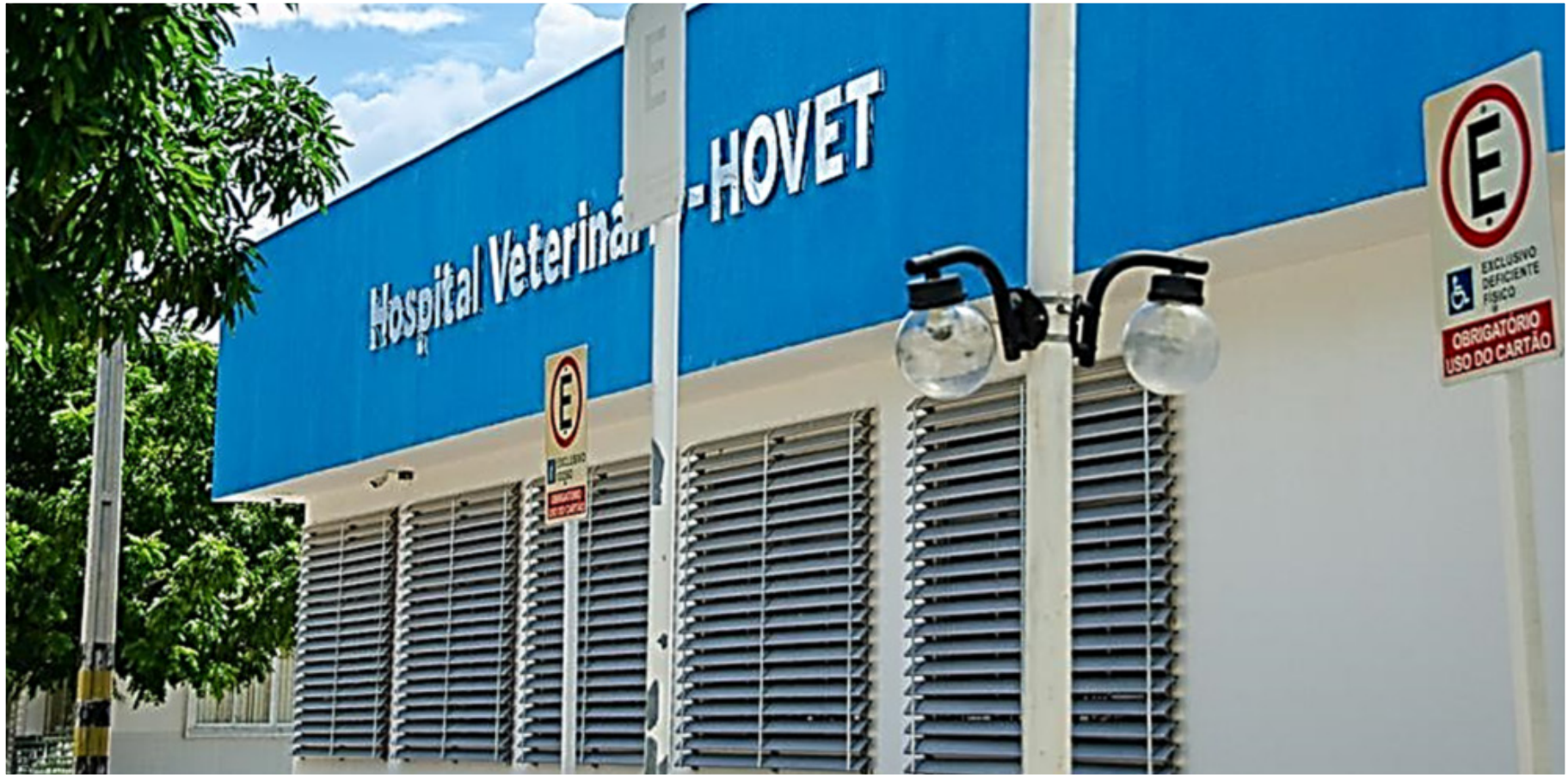
FIGURA 91 – HOSPITAL VETERINÁRIO DA UFERSA
