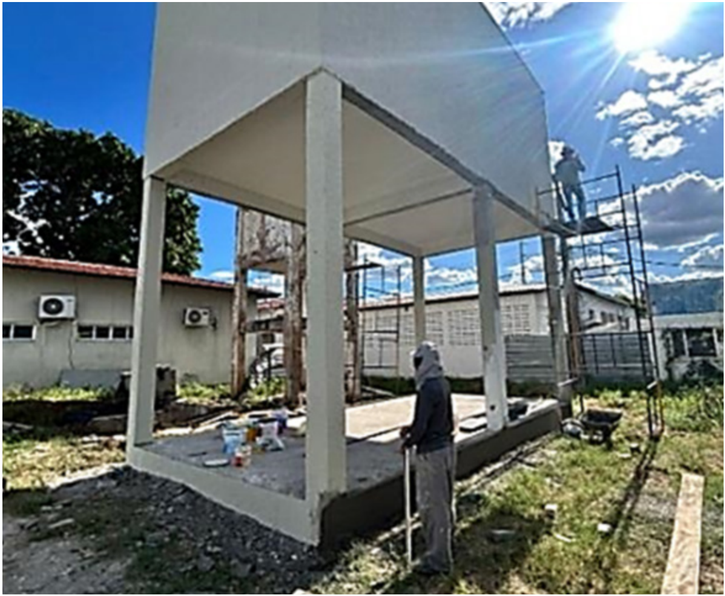
FIGURA 79 - CONSTRUÇÃO DO RESERVATÓRIO ELEVADO DO LASAP
