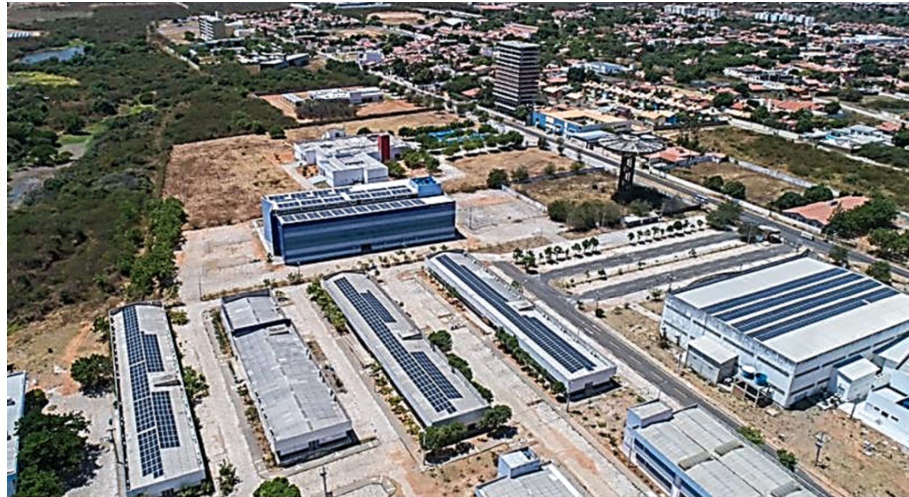
FIGURA 76 - VISTA AÉREA DE ALGUMAS DAS USINAS SOLARES DO CAMPUS DE MOSSORÓ
