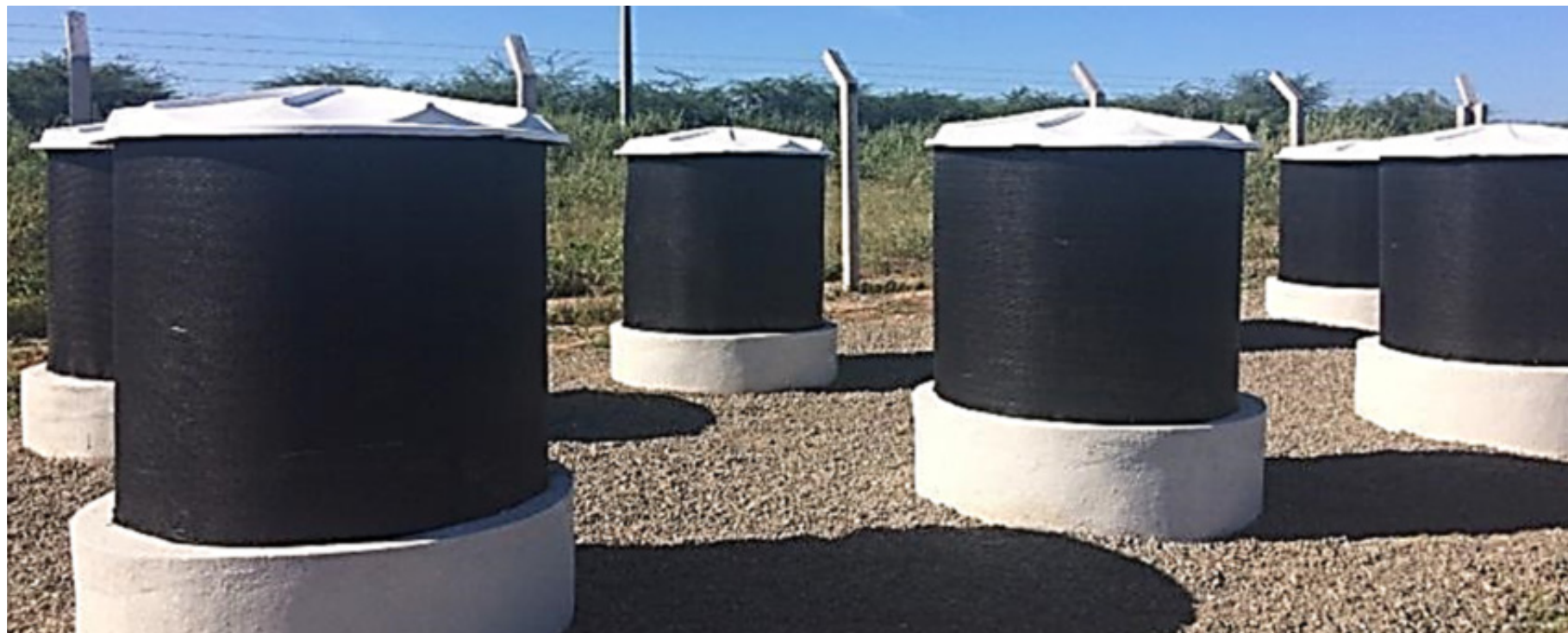
FIGURA 73 – USINA DE COMPOSTAGEM DO CAMPUS MOSSORÓ DA UFERSA
